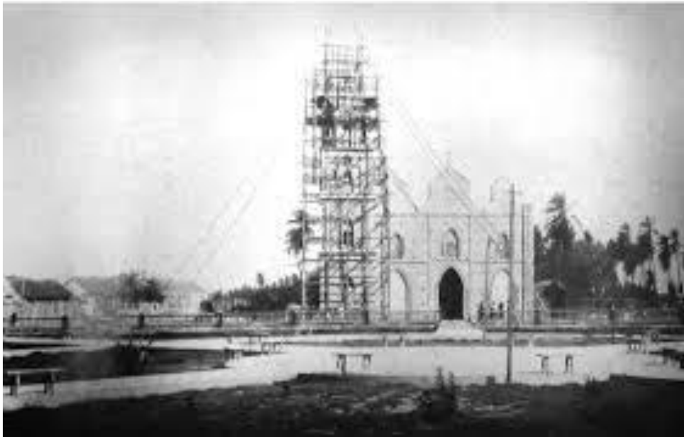
Construcción de la primera torre del templo San Rafael Arcángel de El Moján
